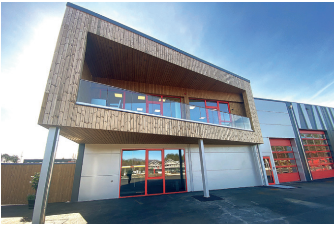
Balkong med sittegrupper under tak i andre etasje, hvor kantine og undervisningsrom ligger innenfor.
